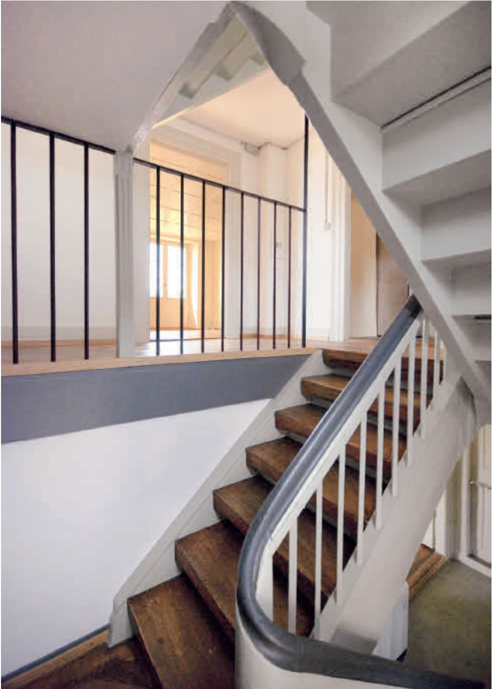
Treppenhaus kurz nach der Renovation, 2009 (Foto Archiv Ritterhaus-Veredigung).
