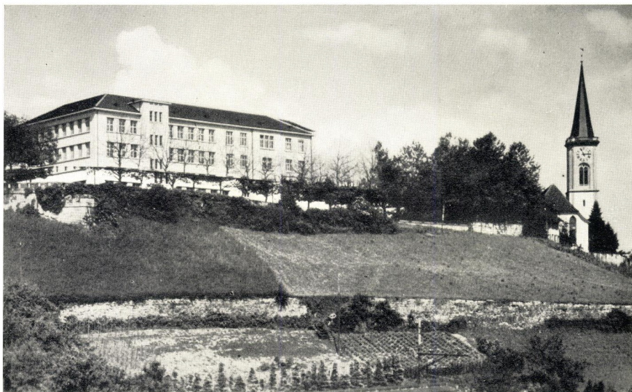
Ansicht des Oberstufenschulhauses von der Seeseite
