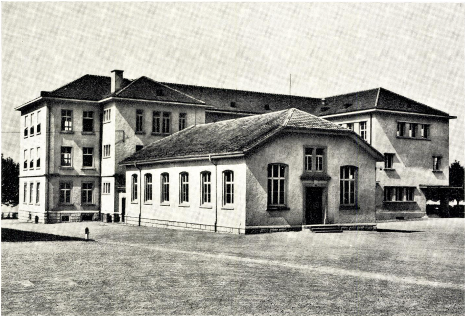
Das Oberstufenschulhaus vor der Erweiterung Im Vordergrund die alte Turnhalle, die später abgebrochen werden soll
