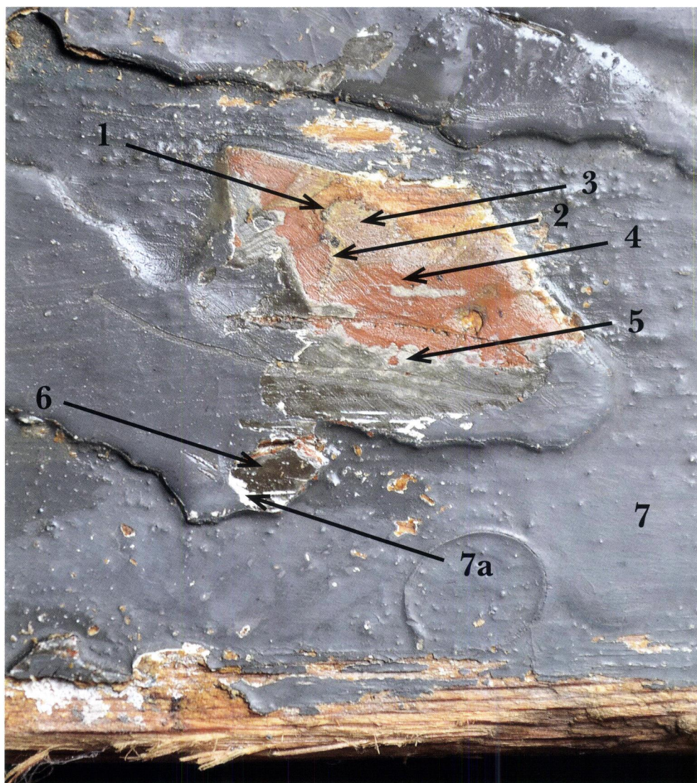
Abb. 14: Detailaufnahme der Farbschichtensondierung im Schwellenbereich des rechten Flügels der ältesten erhaltenen Rundbogentüre (aussen). Die Schichten haben folgende Farbtöne:
