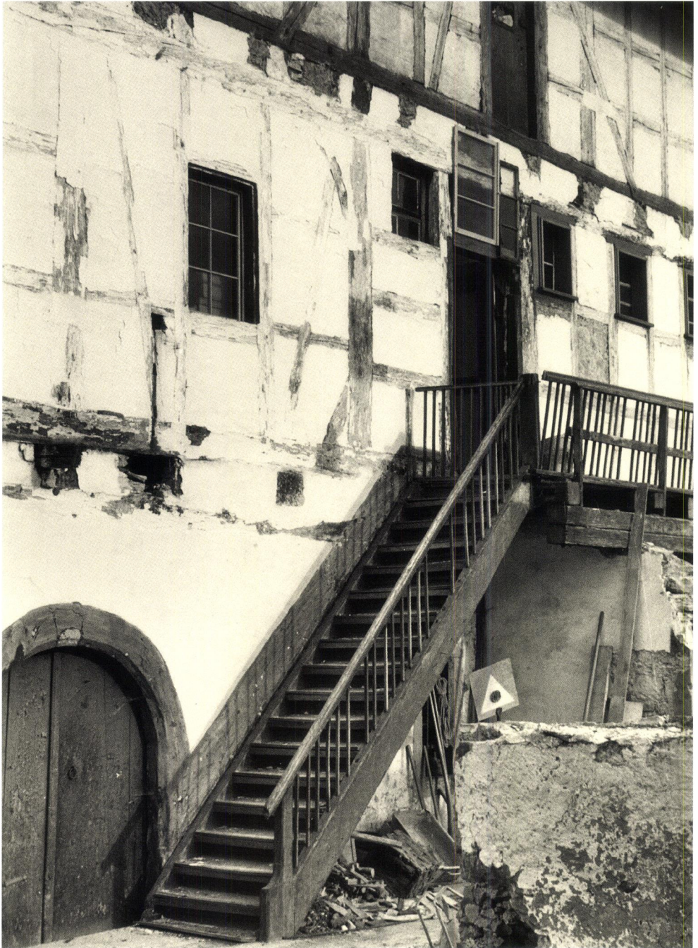
Abb. 6: Westfassade nach dem Abbruch des Schopfanbaus, 1950 (Foto Ritterhaus-Vereinigung Üriikon-Stäfa).
