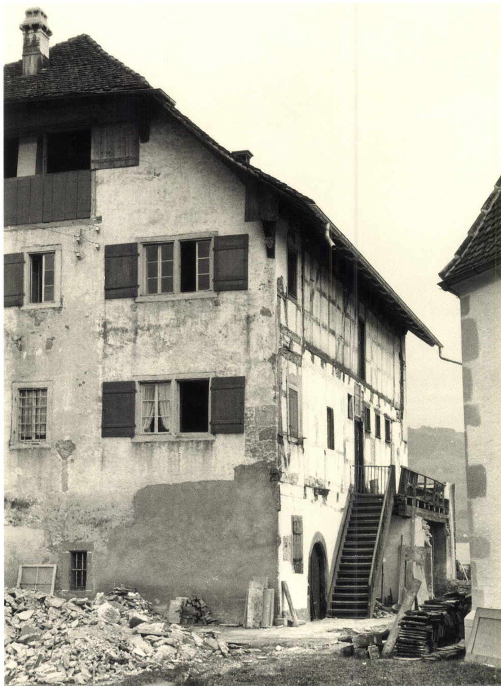
Abb. 8: Nordwestseite nach dem Abbruch des Schopfanbaus, 1950 (Foto Ritterhaus-Vereinigung Üriikon-Stäfa).
