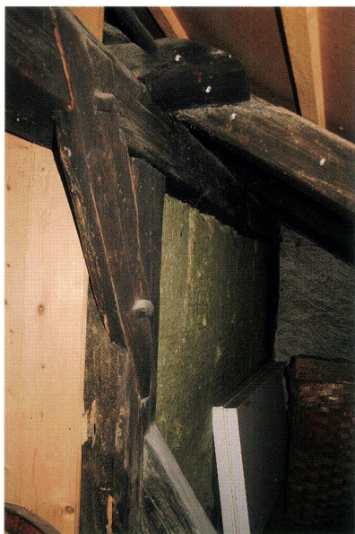
Ständer mit Fuß- und Kopfstreben des Dachstuhls von 1550 im Teilhaus Seestrasse 125.
