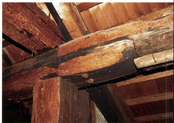
Kopf der seeseitigen Mittelfette des Dachstuhls von 1550 und daran ange-setzte Pfette der Verlängerung von 1574 im Teilhaus Zehntentrotte 4. Der Russ auf den Balken ist in neuester Zeit unnötigerweise weggebeilt worden.
