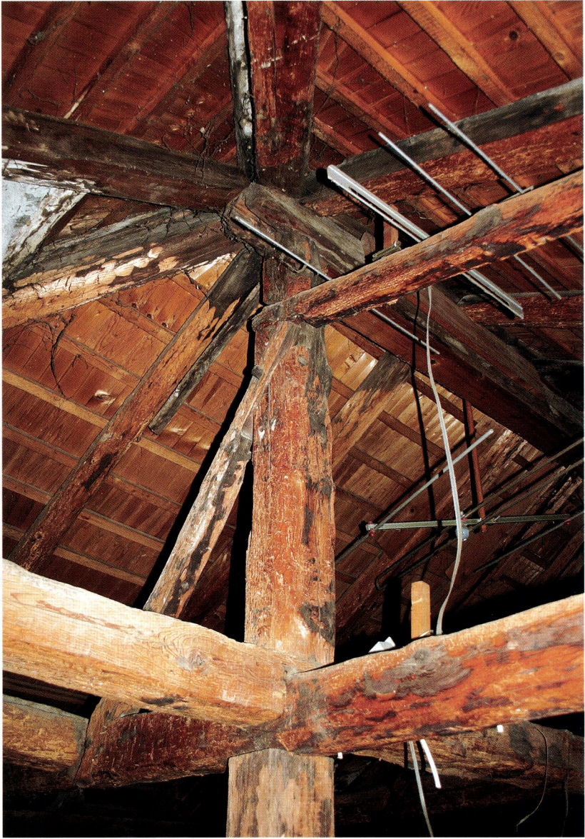
Dachstuhl mit Krüppelwalm des Hausteils, der um 1574 an das Gebäude von 1550 angefügt worden ist und das Haus um rund die Hälfte verlängert hat.
