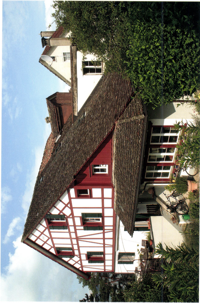
Im 19. Jahrhundert erstellte, früher verputzte Riegelwand anstelle der ursprünglichen Holzwand (Bohlenständerwerk) des Hauses von 1550. Am Ort des Anbaus mit herabgeschlepptem Dach gab es früher ein Trotthaus.
