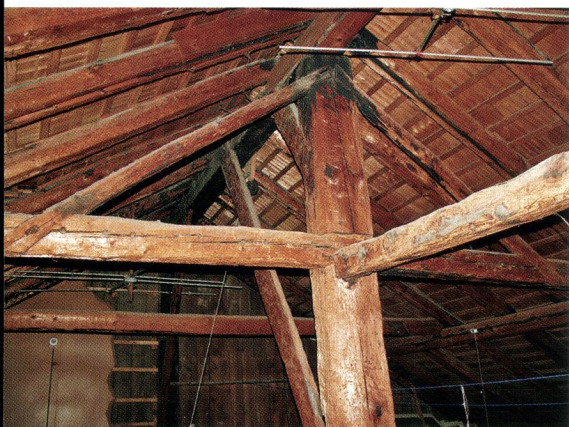
Firstständer mit Kehlbalken und Streben beim ursprünglichen, nordwestlichen Abschluss des Hauses von 1550. Im Kehlbalken sind die Reste der Holznägeln zu sehen, mit denen die Bretter der Giebelwand fixiert waren.
