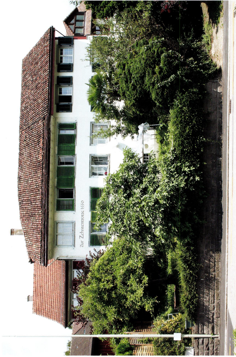
Das um 1550 erbaute Haus war ursprünglich ein Holzbau über einem gemauerten Kellergeschoss. Es wurde 25 Jahre später um einen Drittel verlängert und das Dach des neuen Teils mit einem Krüppelwalb abgedeckt.
