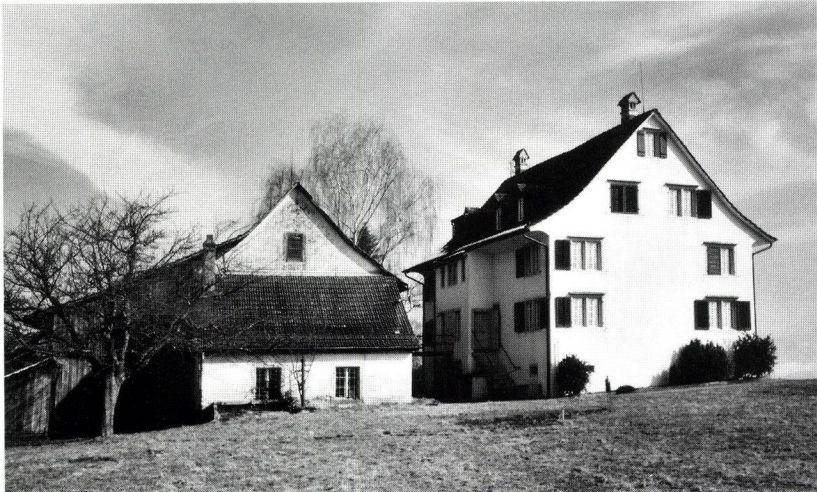
Wohnhaus und Ökonomiegebäude bilden eine Einheit.
