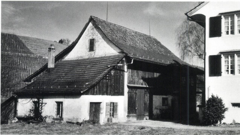
Der Pumpbrunnen neben dem Waschhaus ist längst ausser Betrieb.
