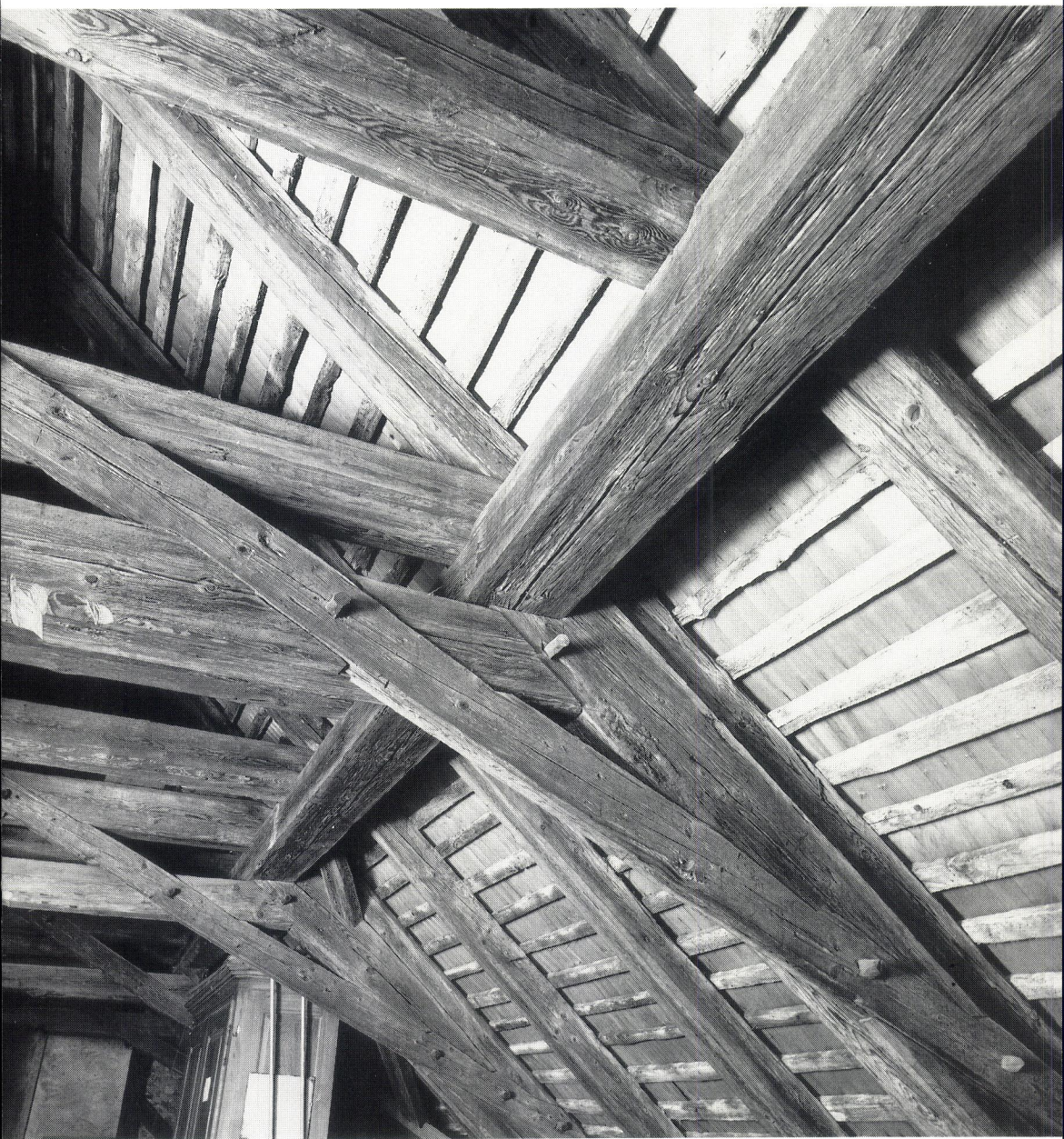
Ritterhaus, Nordteil, Westseite nahe Boden
