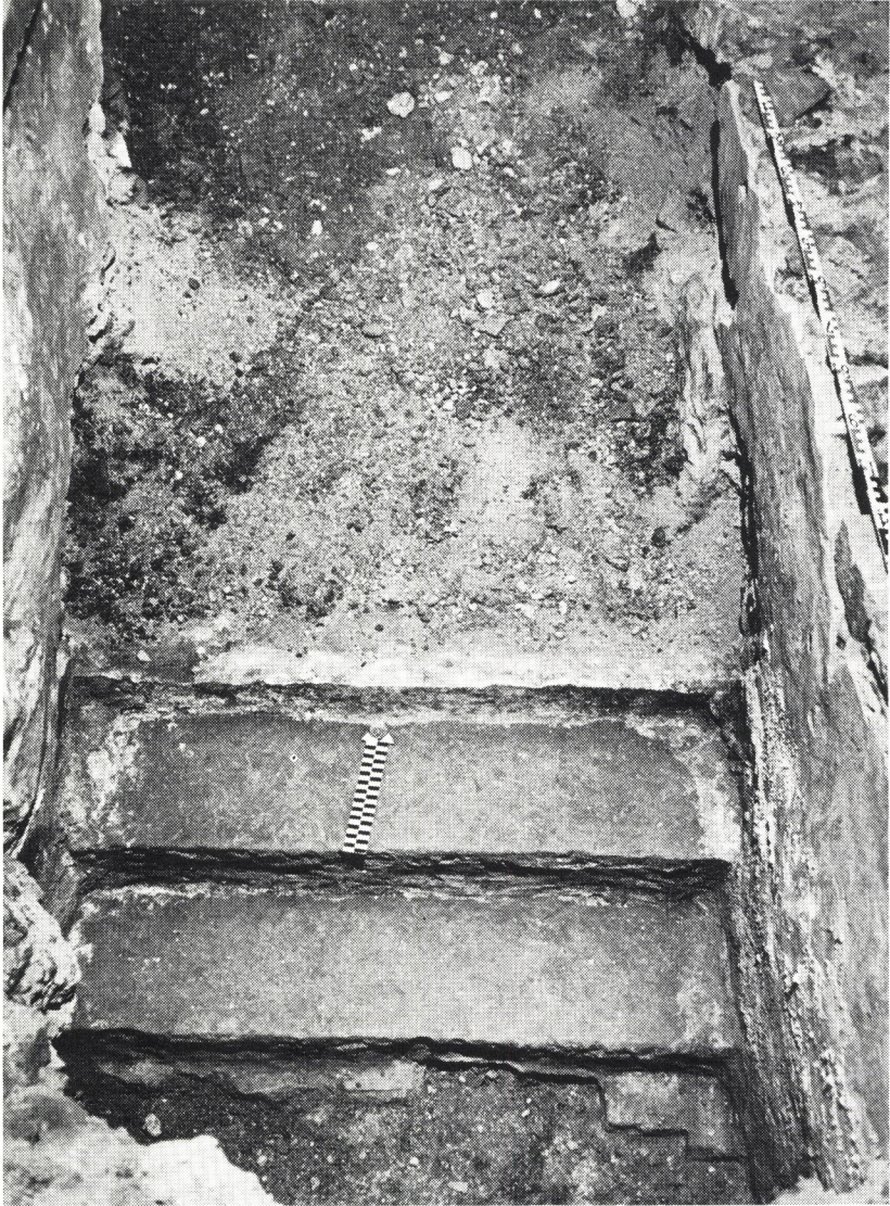
Die noch erhaltenen untersten Stufen der ehemaligen Kellertreppe. Vor der untersten Stufe sind Reste des Tonplattenbodens erkennbar.
