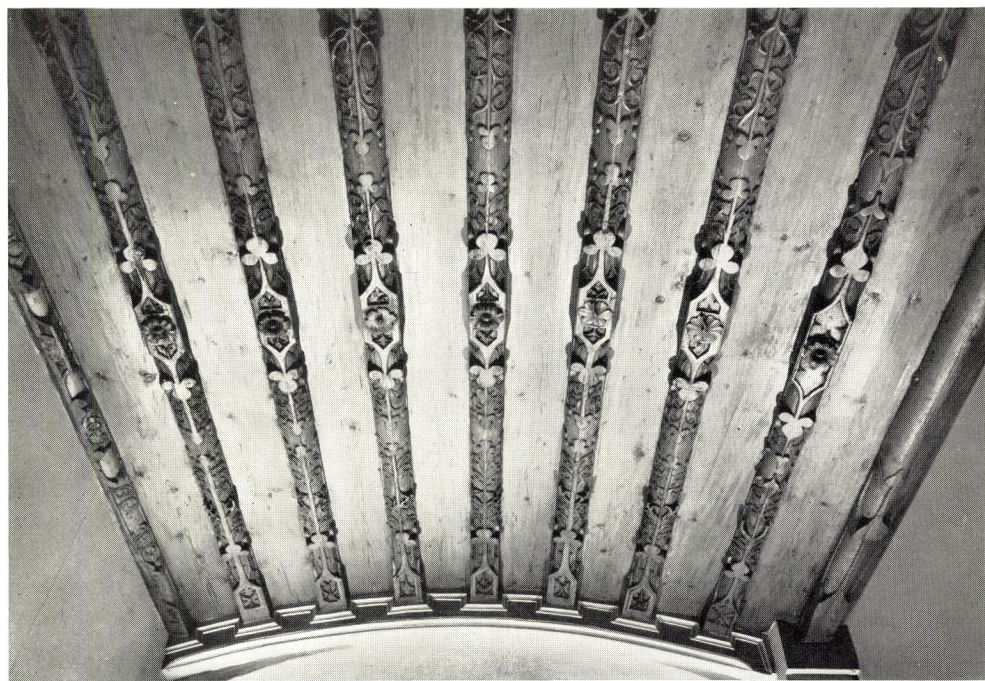
St. Gallen, nachgot. Bohlenbalkendecke Ende 16. Jh. im Haus zum Liegenden Hirsch, Spisergasse Nr. 41.
