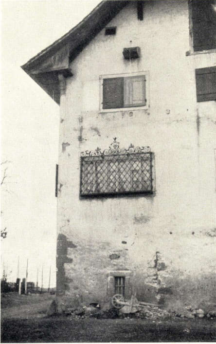
Nordostecke mit angehängtem Teil B und Baufuge
